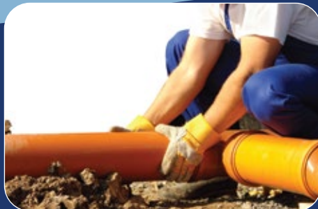
CPVC PIPE FIXING تثبيت أنابيب CPVC
