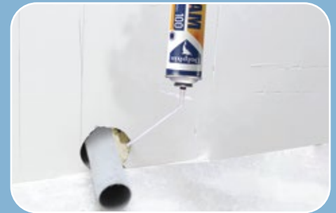
PIPE HOLE FILLING ملئ فجوات الأنابيب
